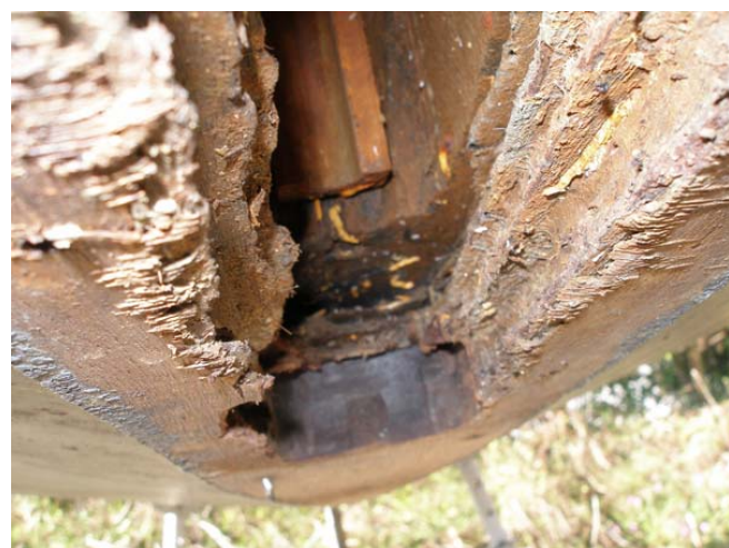
Puits de quille, vue d'en haut, l'arrière est à droite. Détail vue d'en bas, vers l'avant
